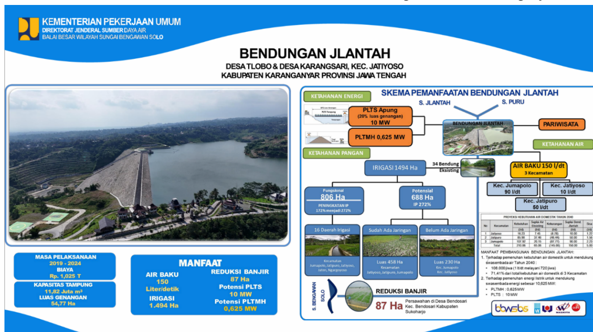
Gambar 3. Kondisi eksisting Waduk Jlantah
