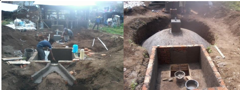
Gambar 4. Pembuatan reaktor biogas
