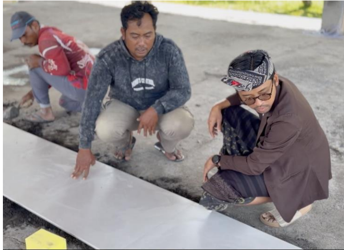
Gambar 5. Proses setting out: penentuan starting point dan kesikuan pemasangan granit Sumber: Dokumentasi tim pengabdian, 2026
