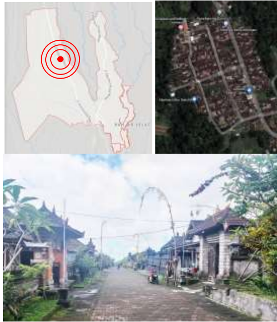
Gambar 4. Kondisi Eksisting Permukiman Pura Kancing Gumi Sumber : Gunawarman, 2021
