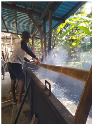
Gambar 5. Kegiatan dan proses pengawetan bambu oleh Mitra (Sumber: Survey Lapangan, 2022)
