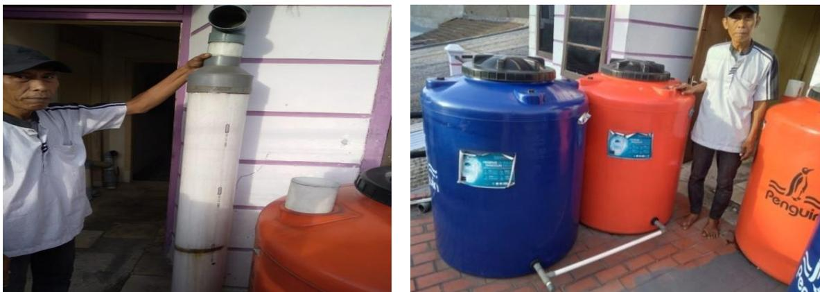
Gambar 2. Pralon sebagai delivery system air hujan dari atap rumah ke ke penampungan (toran)
