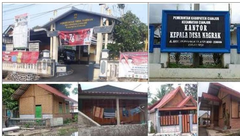
Gambar 2: Kondisi bangunan di Desa Nagrak sebelum peristiwa gempa bumi 2022 Sumber: Dokumentasi, 2021
