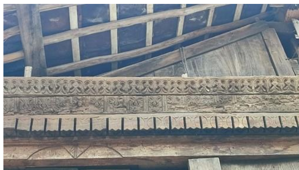
Gambar 7 Ornamen Dinding 3 Kerajaan Sumber : Dokumentasi Pribadi
