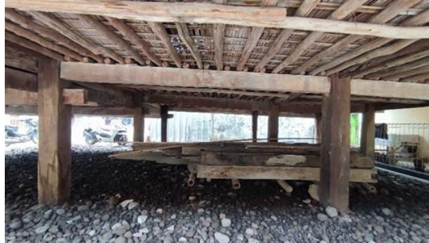
Gambar 5 Tiang Pondasi Sumber : Dokumentasi Pribadi
