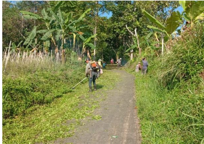
Gambar 3. Pembersihan Lahan Sekitar Saluran Drainase
