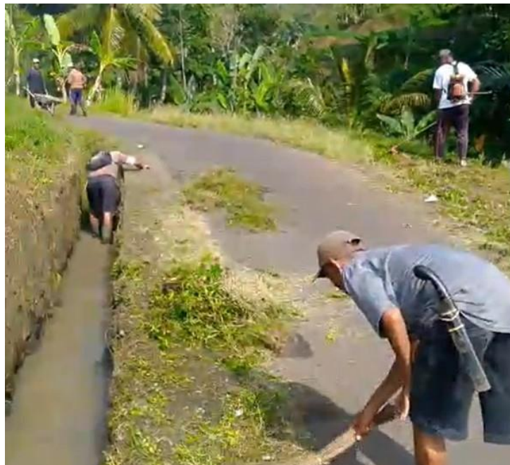
Gambar 3. Pembersihan Saluran Drainase.
