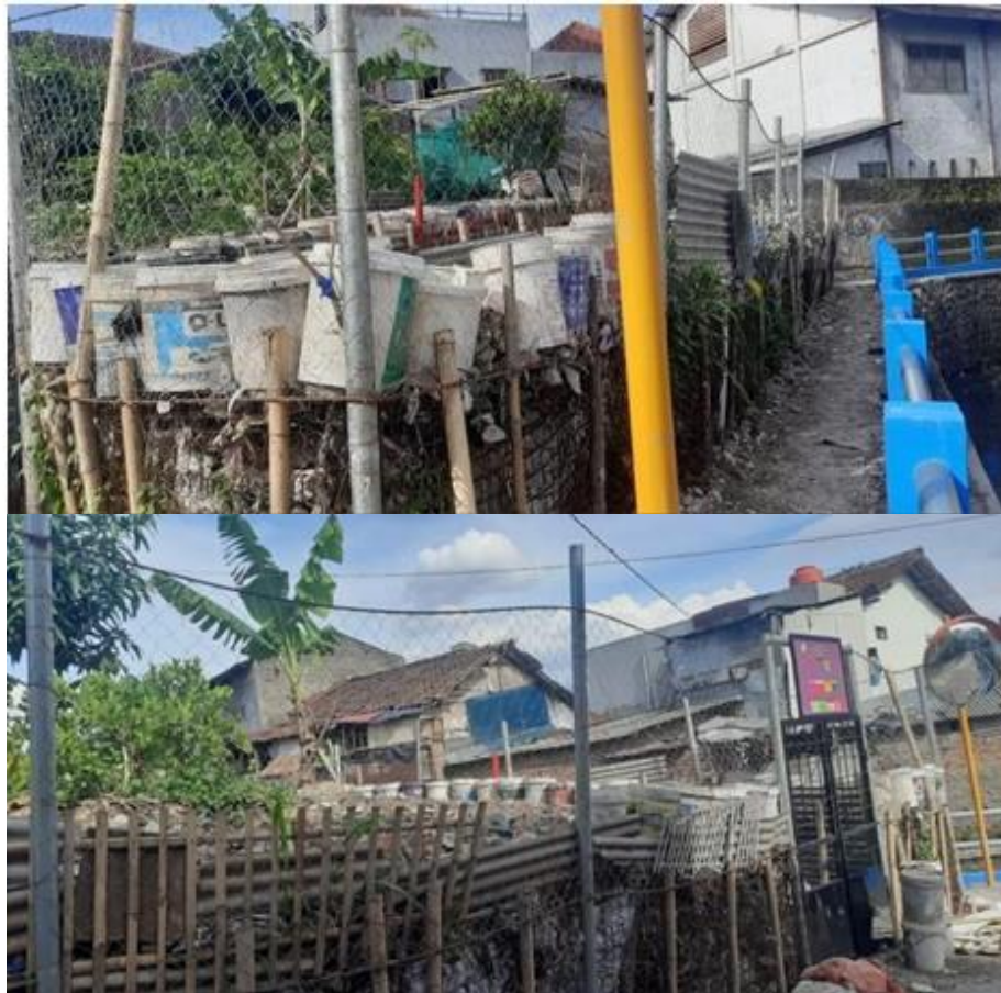
Gambar 6. Hasil Akhir Pemasangan Pagar Pembatas Taman Buruan SAE Sumber: Dokumentasi Penulis
