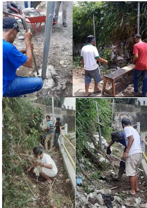
Gambar 5. Pemasangan Tiang Pagar
