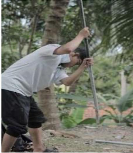
**Gambar 1.** Proses penggalian lubang untuk tiang cermin cembung
