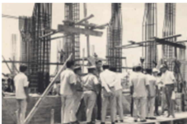
Gambar 2. Pembangunan pabrik penggilingan gandum PT. Bogasari Flour Mills di Tanjung Priok, Jakarta, pada 19 Mei 1969
