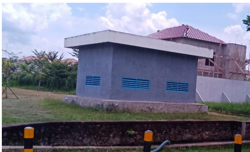
Gambar 11. Ruang genset di Autumn Forest Sumber: Pribadi
