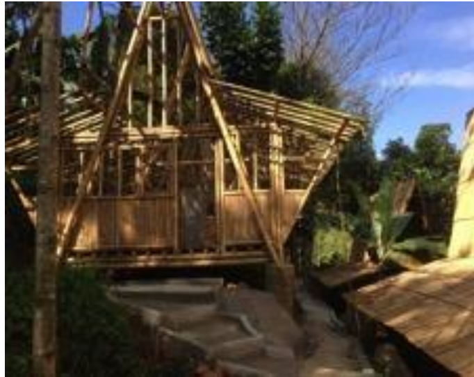
Gambar 2. Bangunan fungsi wisata yang menjadi sampel penelitian Sumber: Ferdelina, 2016
