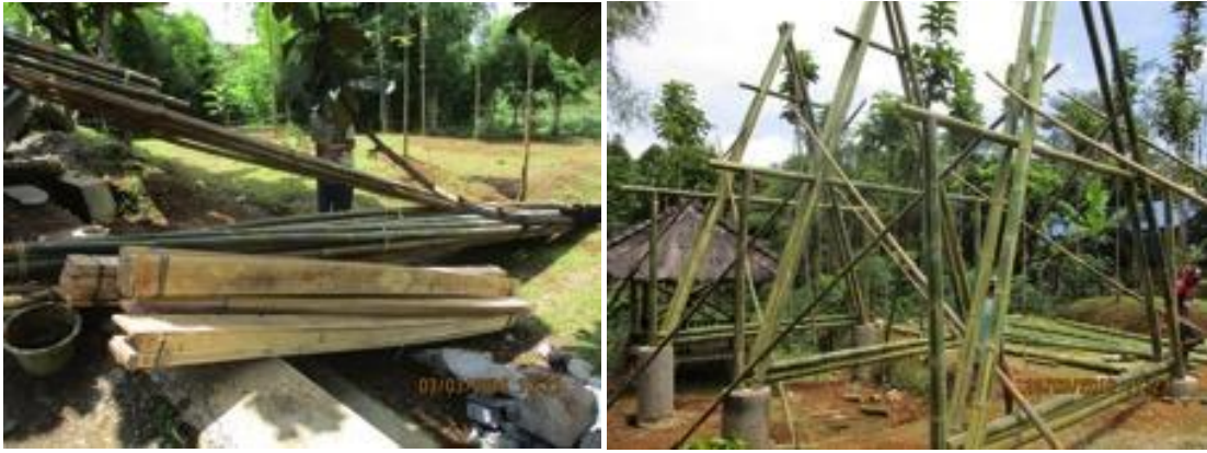
Gambar 4. Material kayu dan bambu sebagai komponen utama bangunan (kiri) dan proses konstruksi bangunan (kanan).
