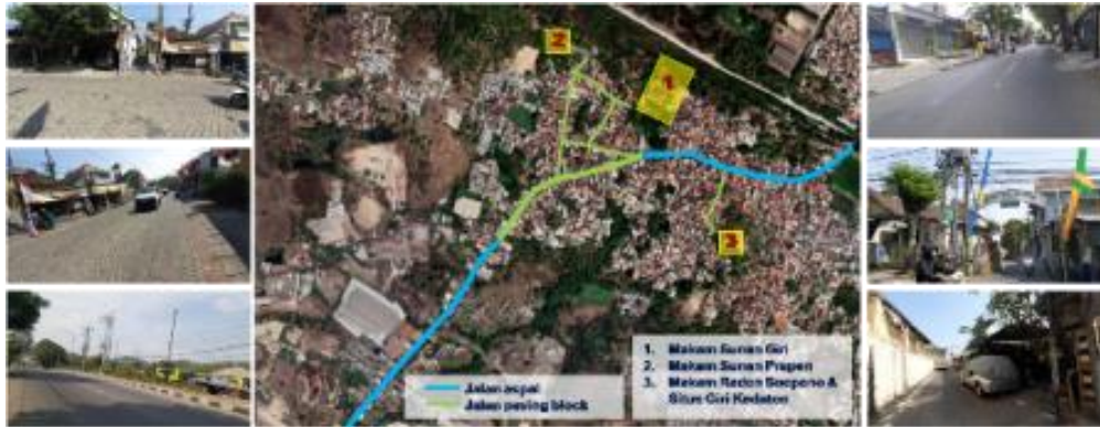
Gambar 7. Kondisi Eksisting Jalan sebagai Penunjang Transportasi
