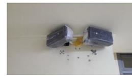
Gambar 8 Speaker koridor Lt. 16 Tower A untuk kepentingan evakuasi
