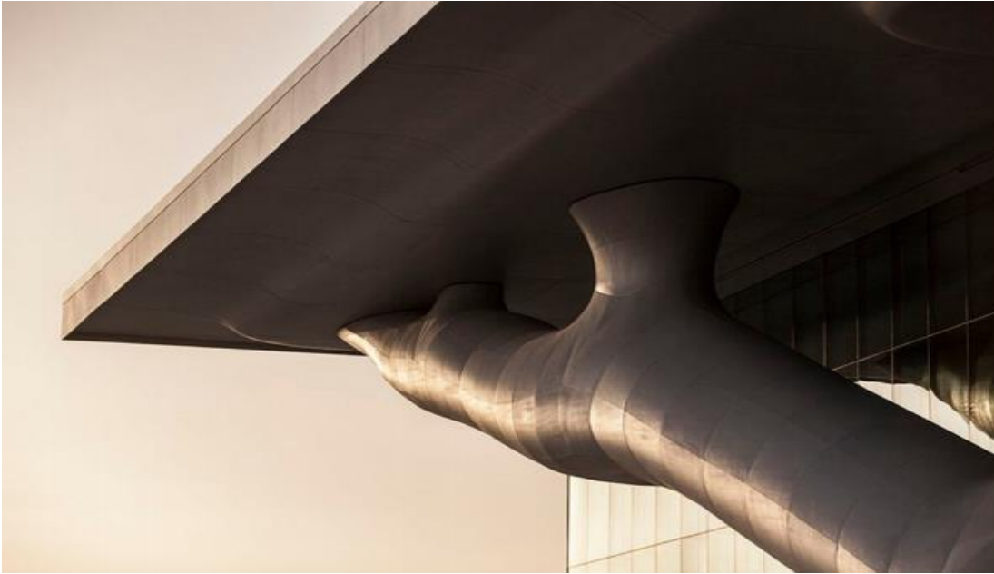
Gambar 2. Warna dan Tekstur pada Fasad QNCC Sumber: ArchDaily, 2013
