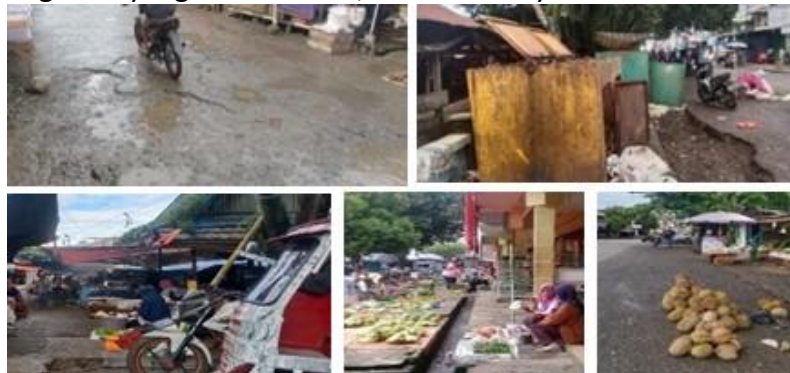
Gambar 1.1 Kondisi Eksisting Pasar Purwodadi (Sumber : Dokumentasi Penulis, 2022)
