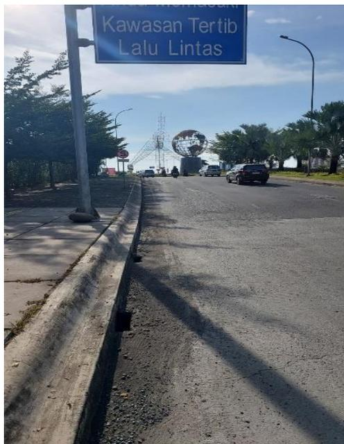
**Gambar 4.5. Lubang Pada Bahu Jalan Di Kawasan CPI Untuk Mengalirkan Air Ke Dalam Saluran Bawah Tanah Agar Mencegah Terjadinya Genangan Air Di Jalan**
