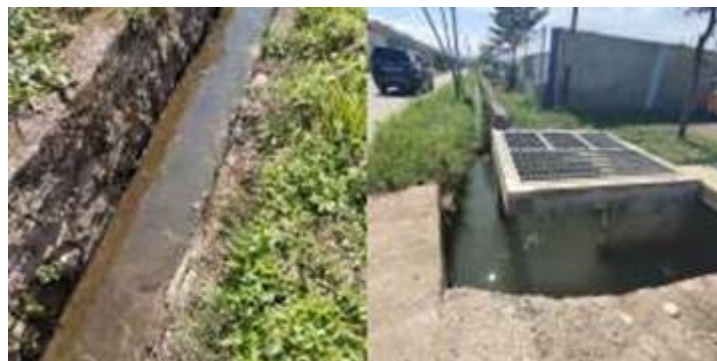
Gambar 17. Jaringan Drainase (Sumber:Dokumentasi Pribadi, 2024)
