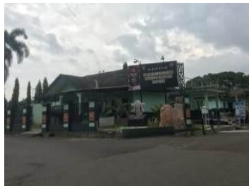
Gambar 20. Pussenarhanud Sport Center (Sumber: Dokumentasi Pribadi, 2024)
