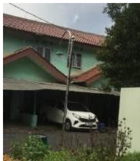
Gambar 12. Penerangan Jalan Perumahan Pussenarhanud (Sumber: Dokumentasi Pribadi, 2024)
