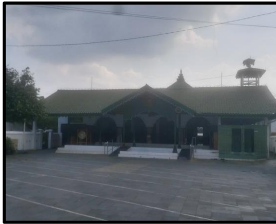
Gambar 2. Ruang Utama Masjid (Sumber: Data Pribadi, 2024)
